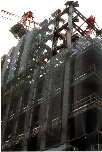
鉄骨建方に使用
